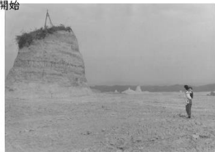
右京地区 山を削って平地に。 測量起点部は取り残されている
